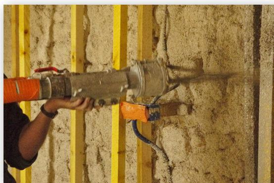
Projection d'un enduit isolant (béton chaux-chanvre).
