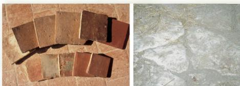
7 Sol sur terre-plein constitué de carreaux de terre cuite posés sur mortier de terre ou de chaux, ou plus rare d'un dallage en pierre.
