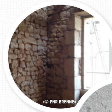
Paroi nettoyée de ses enduits ciment avant mise en œuvre du complexe isolant.
