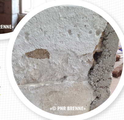
Paroi nettoyée de ses enduits ciment avant mise en œuvre du complexe isolant.
