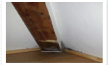
La température superficielle au niveau des ponts thermiques est plus basse que celle environnante. Point de condensation privilégié par temps froid par hausse du rapport humidité intérieure /extérieure.
