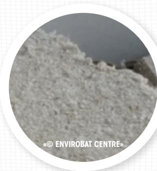
Méconnaissance des conditions de découpe des matériaux. Déchirement du Matériau.
