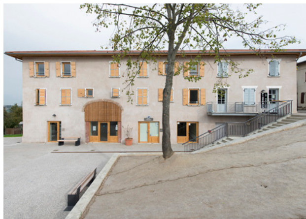
© V. Rigassi – Logements sociaux et commerces – Montseveroux (38)
