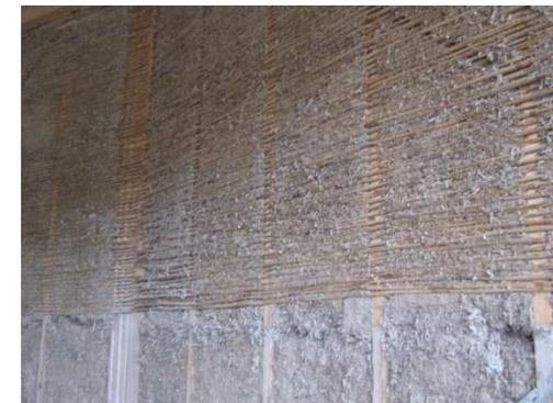
Béton projeté isolant
